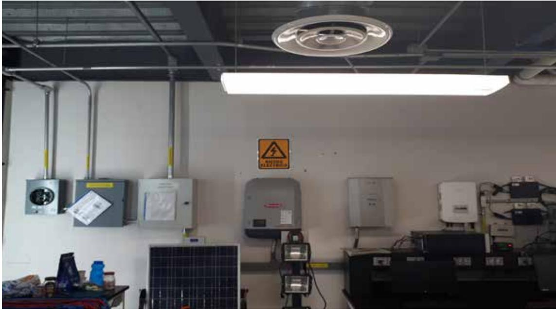
**Figura 12.** *Inversores de la terraza fotovoltaica.*
